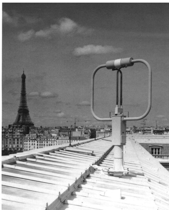
Figure 9 – Antenne boucle HF installée sur le toit d'un bâtiment (Document STAREC)
